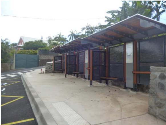
Quai réhaussé pour accessibilité des personnes à mobilité réduite
