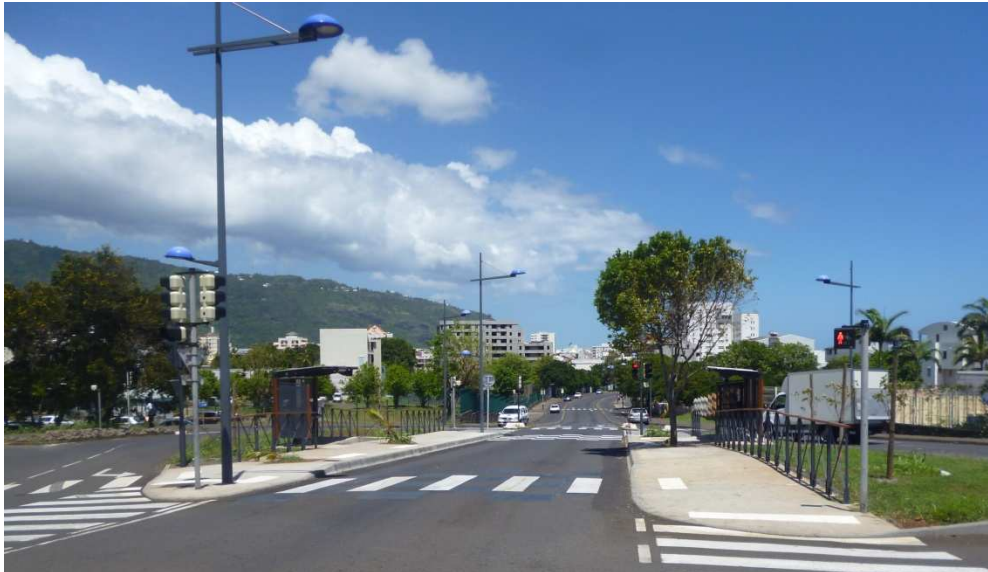
Avenue de Lattre de Tassigny – voie de T.C.S.P. Trottoirs en béton balayé
