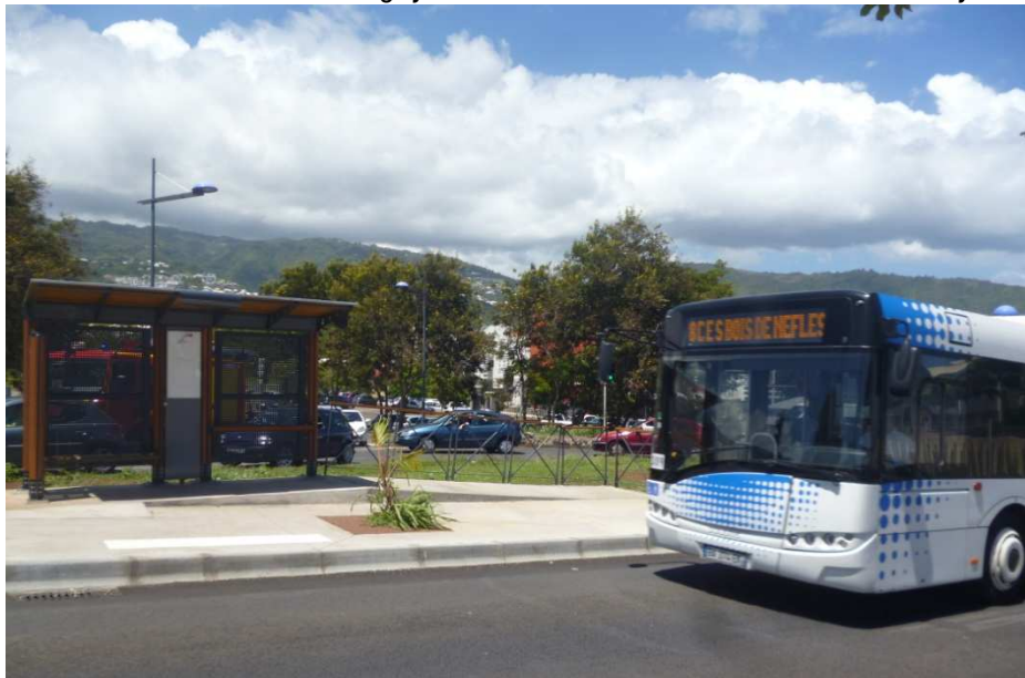
Quais réhaussés afin de permettre l'accessibilité des transports en commun aux personnes à mobilité réduite
