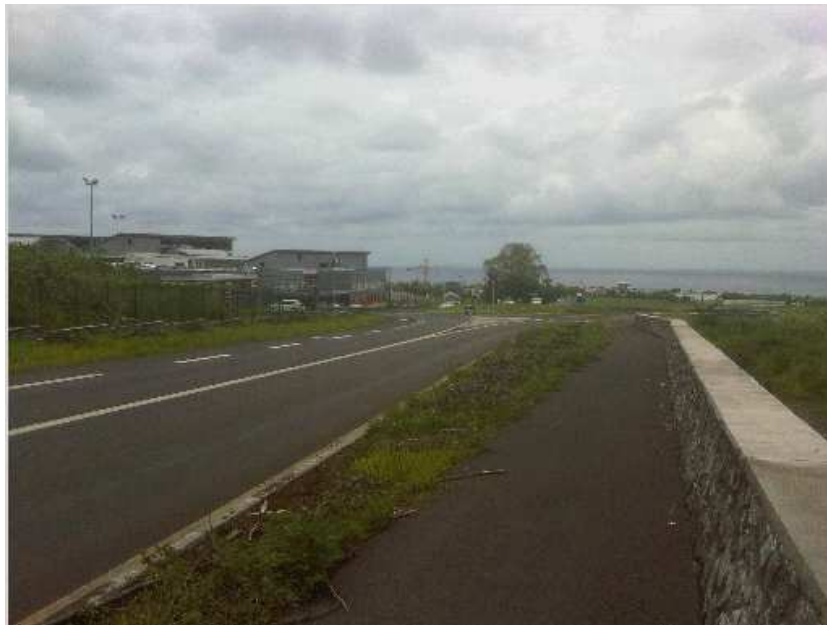
Aménagement réalisé (Source : Région Réunion)
